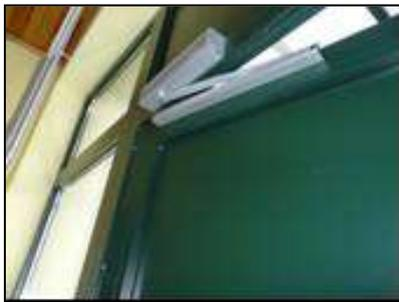
Pour limiter les « oublis » de portes ouvertes entre locaux chauffés et non chauffés, la majorité des portes a été équipée de « retours de porte ».
