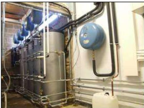
Le bureau d'études Concept'Eco Energy a déterminé et mis en œuvre la solution choisie en 2010 : coupler solaire thermique et pompes à chaleur pour assurer l'intégralité de la fourniture d'ECS et le préchauffage de l'eau pluviale utilisée par les 7 machines à laver.
