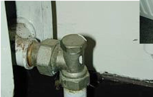
Té de réglage du débit d'un radiateur
