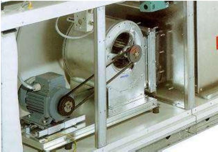
*Vérification de la tension des courroies de transmission d'un ventilateur*
