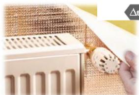
Placer un isolant de 0,5 cm recouvert d'aluminium sur un mur non isolé au dos d'un radiateur permet de gagner :
