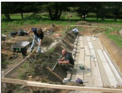
**Quoi?** L'EFT Le Trusquin développe une technique innovante d'épuration et de valorisation des eaux dénommée "phytoépuration". Ce type d'épuration n'utilise pas d'énergie, est bon marché, très efficace et simple à installer. La phytoépuration s'adresse tant à des particuliers qu'à des entreprises. La priorité est de développer les compétences des formateurs de l'EFT afin de créer une nouvelle filière de
