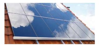
Pour constituer un panneau (le terme technique est module), les cellules sont assemblées, reliées électriquement et encapsulées, afin d'obtenir une tension suffisante et de les protéger des chocs et de l'humidité.
