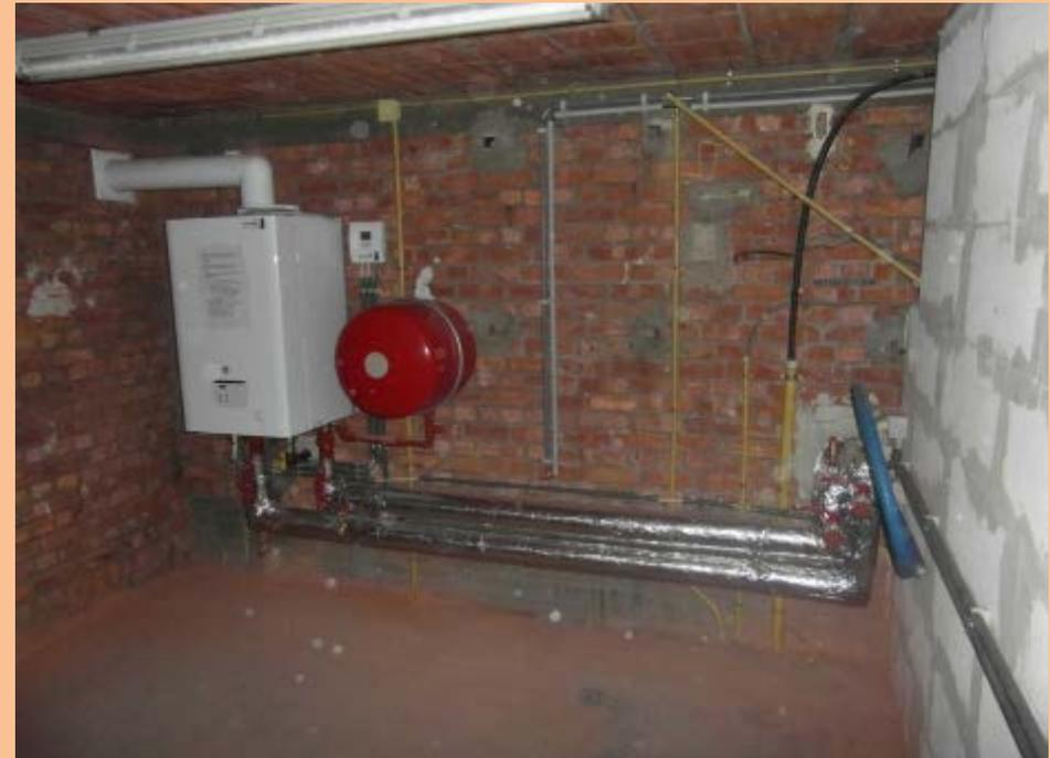
• **Situation projetée** : Chaufferie déplacée – placement d'une (ou 2) chaudière gaz à condensation - Radiateurs dans les bureaux (eau chaude)
