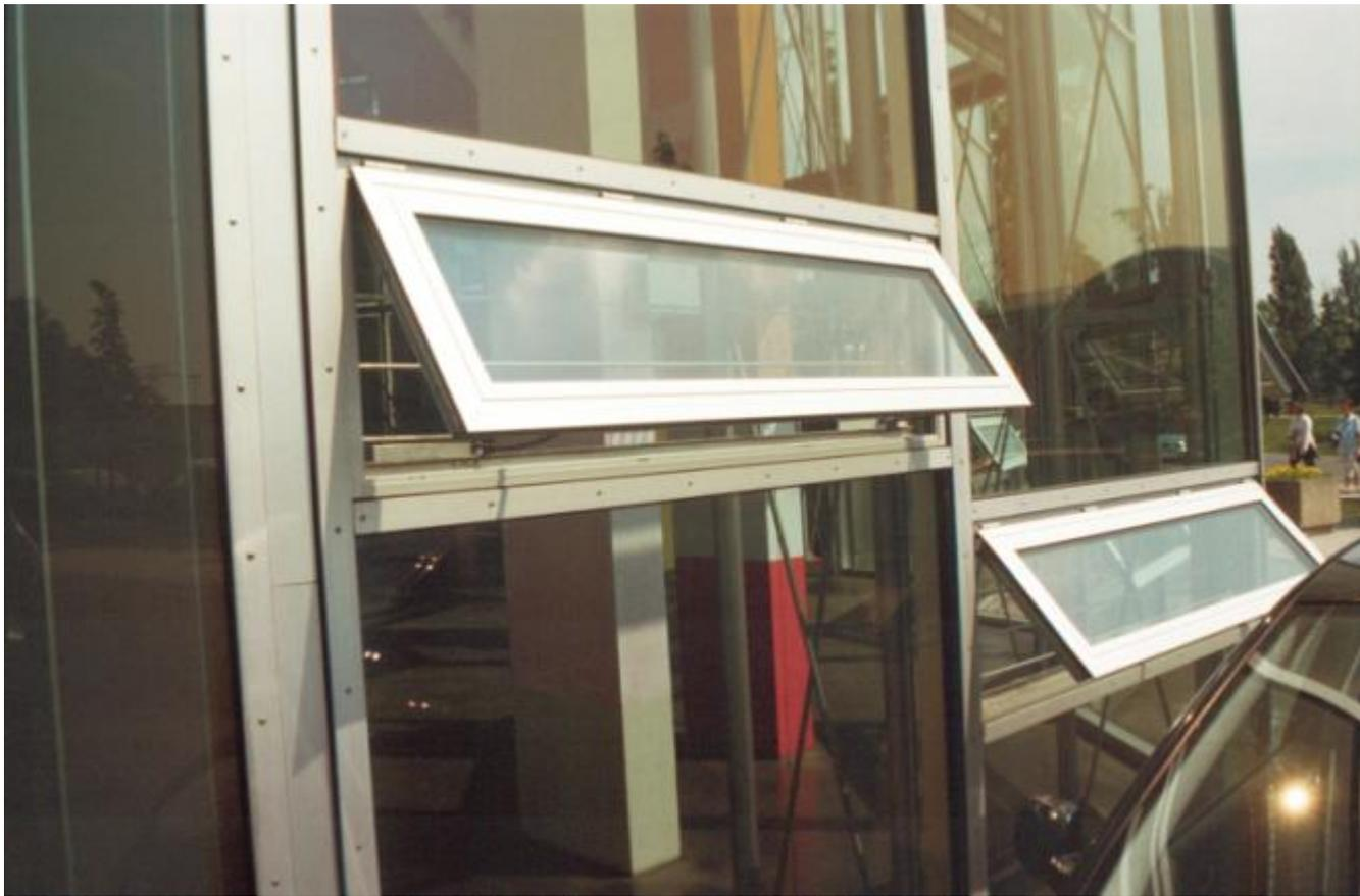
Idéalement, on profite d'un **effet de cheminée** intérieur entre 2 fenêtres situées à des hauteurs différentes.
